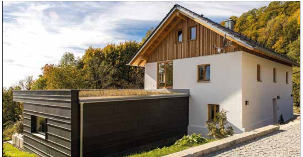
Um zusätzlichen Wohnraum zu gewinnen, entschied sich die Bauherrenfamilie für einen Kubus-Anbau von 60 Quadratmetern. (Bild: Haga)
