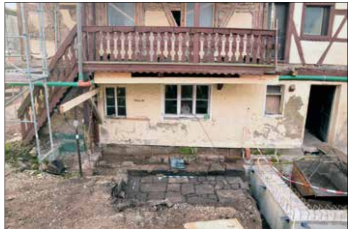
Abb. 2: Gut erhaltene Sandsteinpflasterung im Hofbereich nördlich des Gebäudes
