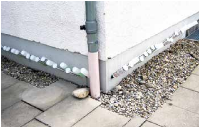
Das schicke Siedlungshaus hatte ein massives Feuchtigkeitsproblem. Eine aufwendige und teure Sanierung drohte.
