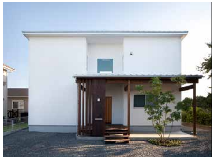
Der diffusionsoffene Edelputz sorgt auch an Fassaden für ein hervorragendes Feuchtigkeitsmanagement und ist schmutzabweisend. (Bildquelle: Haga)
